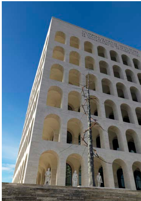
Palazzo Della Civiltà Italiana, FENDI HQ in Rome. Courtesy Palazzo Della Civiltà Italiana.
